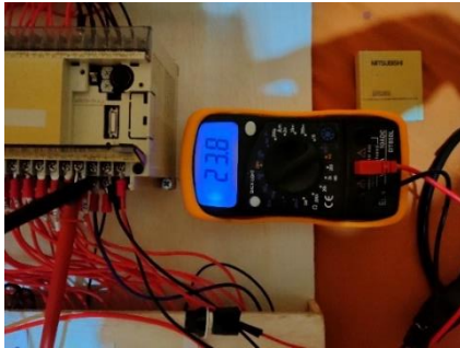
Gambar 8. Pengukuran tegangan pada catu daya PLC
